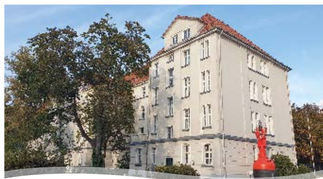
Verwaltungs- und Unterkunftsgebäude des AFZ mit Seiteneingang
