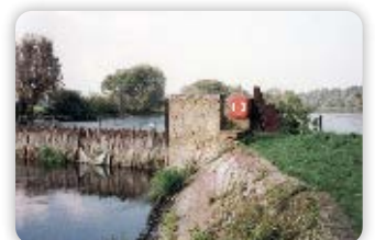
Nadelwehr Garz / Untere Havel-Wasserstraße 1994
