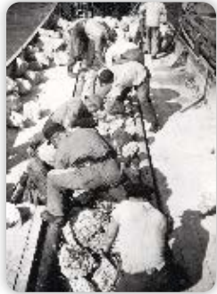
Senkwalzenherstellung im Lastkahn / Rhein
