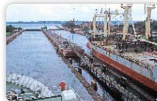
Neue Doppelschleuse Holtenua 1994
