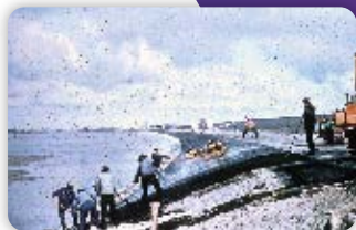
Bau der Schiffsschleusenanlage Eidersperrwerk 1972
