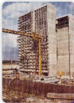
Bau Schiffshebewerk Lüneburg / Elbe-Seitenkanal 1972
