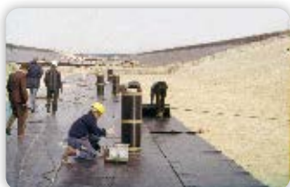
Sanierungsarbeiten nach Dammbruch / Elbe-Seitenkanal 1977
